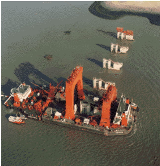
Oosterschelde-stormvloedkering. Materieel te water: de Ostrea bij het plaatsen van de pijlers voor de stormvloedkering
